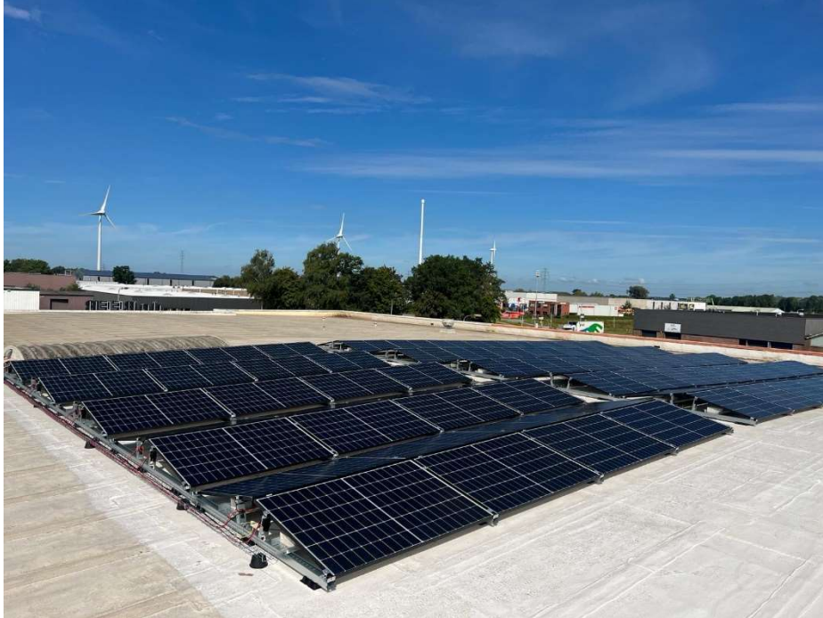
Voorbeeld oost-west opstelling (white backsheet panelen)
